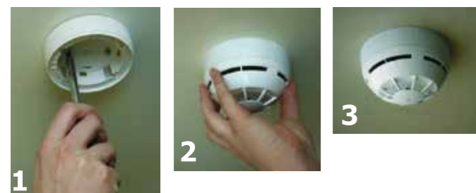
Монтаж радиоканального извещателя.
