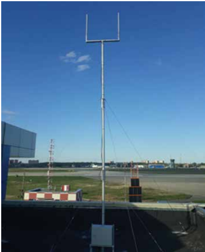
2. Установка ретранслятора на крышу
