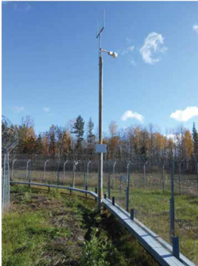
4. Установка ретранслятора на столб
