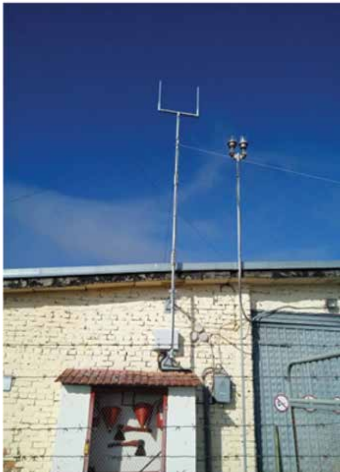
3. Установка ретранслятора на стену
