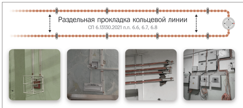
Рис. 1. Монтаж кабельных линий СПА по новым нормативным требованиям
