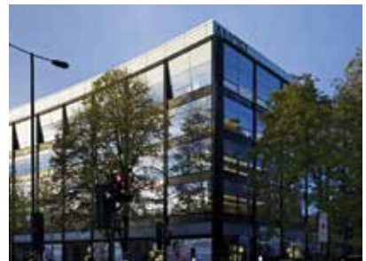
Офисный центр Angelbuilding
