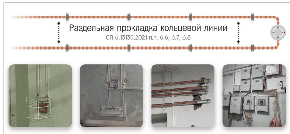
Рис. 1. Реальные примеры раздельной прокладки кольцевой линии
