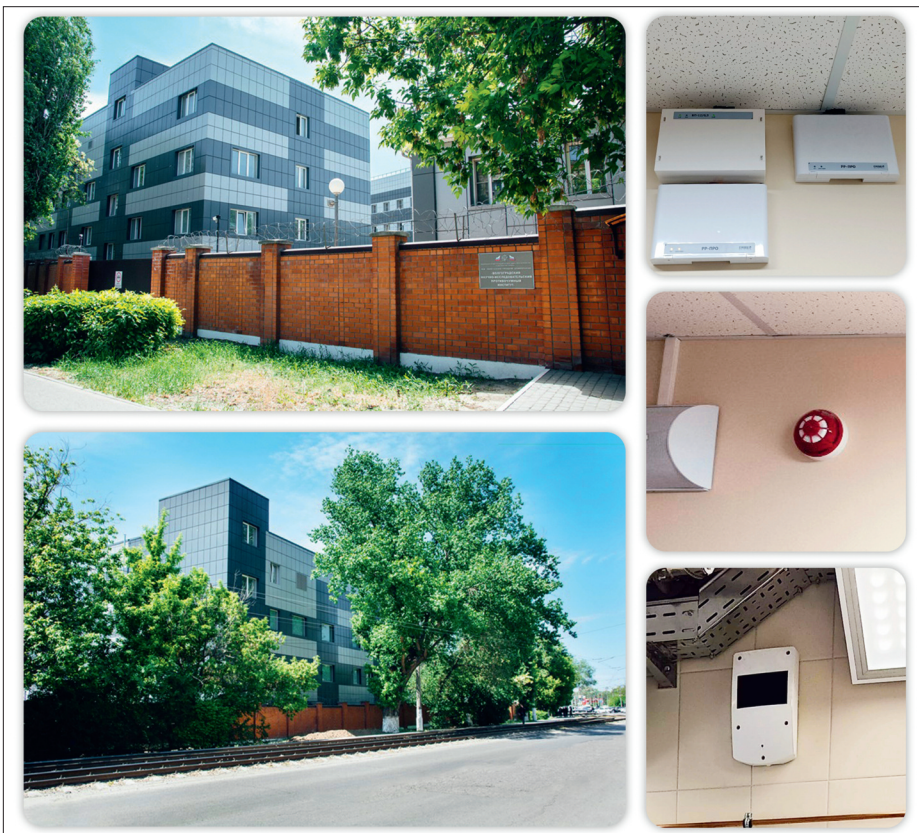
Рис. 1. Новый лабораторный корпус НИИ переоснащен на "Стрелец-ПРО"
