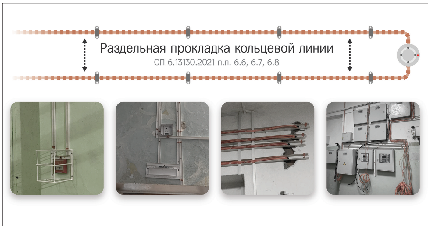
Рис. 3. Раздельная прокладка кольцевой линии
